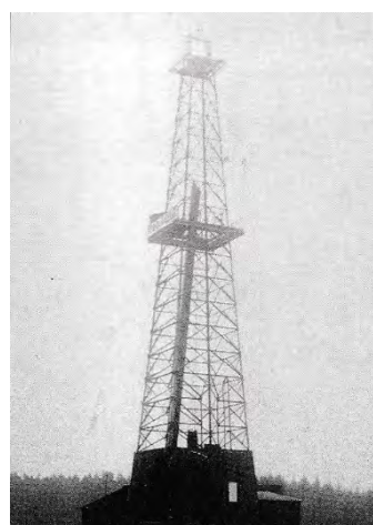
Abb. 19, Erster Bohrturm (1939) im Ried Käferberg.
