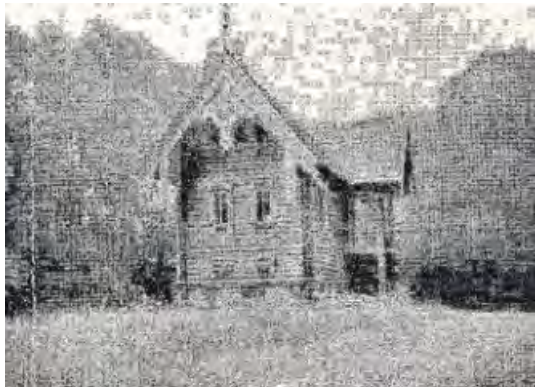
Russenhaus im Revier Hohenau
