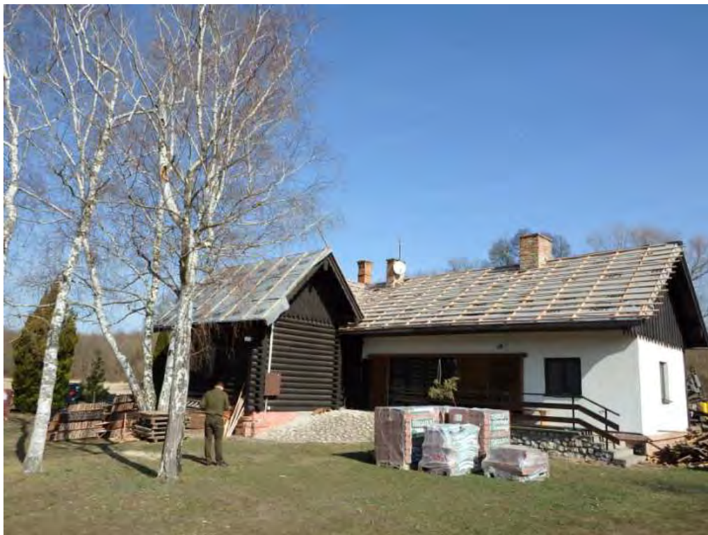
Výměna střešní krytiny. Austausch der Dachdeckung.
