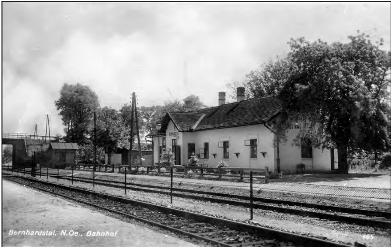
Die Personenhaltestelle um 1930. Rechts hinter dem Baum ist der Brunnen gut sichtbar.
