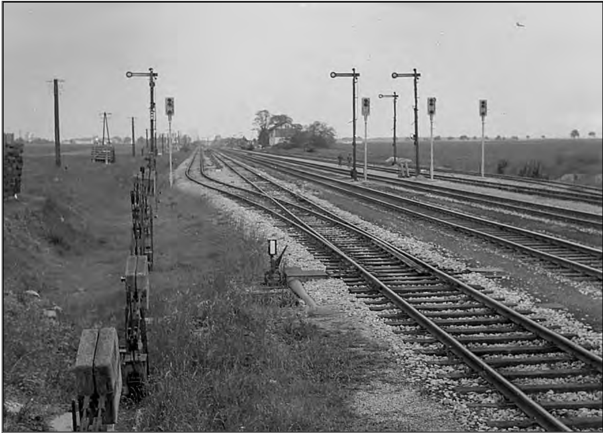
Ausweiche von Süden 1970. Formsignale und neue Lichtsignale nebeneinander.
