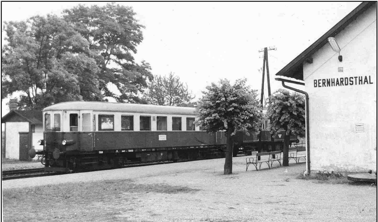
Ein Dieseltriebwagen der Reihe 5042 mit 2-achsigem Dienstwagen bei Ankunft in der Haltestelle. Die Linden sind schon gestutzt. Die Zollhütte bei Bahnsteig 2 steht noch.
