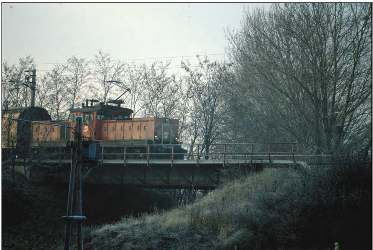
Eine Verschublok der Reihe 1063 auf der Kapellenbrücke
