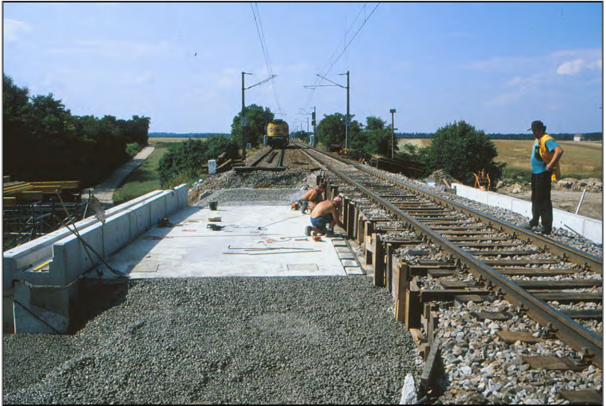
Auch das westliche Auflager ist in Position
