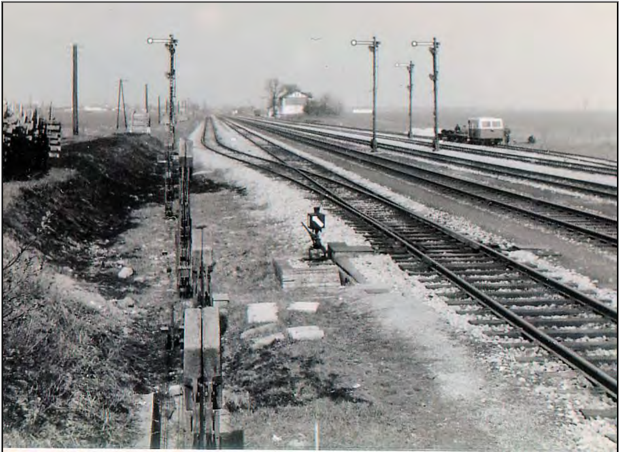
Links stand früher das Stellwerk 1, rechts, an der Ostseite das Bahnwächterhaus 45, Orts-Nr.225. Im Vordergrund die Gewichte zum Spannen der Seilzüge für die Formsignale.
