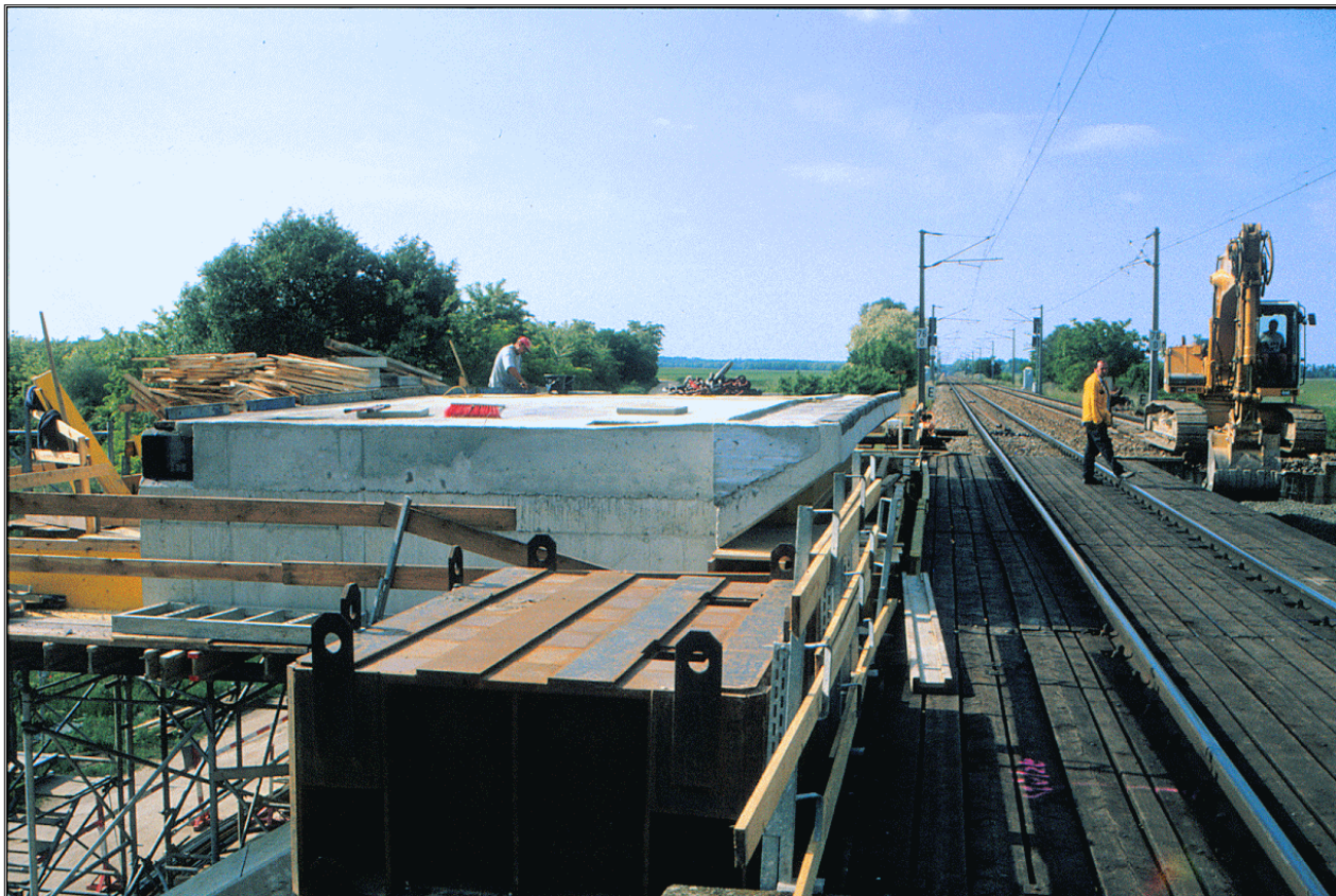
Die Brückenaufleger wurden seitlich vorgefertigt und dann eingeschoben. Mit der gelben Jacke Walter Brunner.
