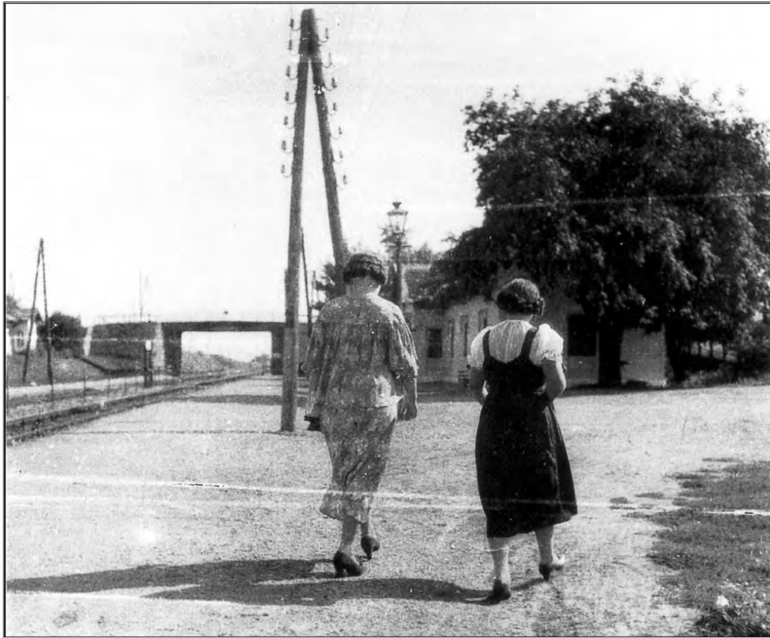
Eines der seltenen Bilder mit der Bahnbrücke, nach 1930. Links und rechts waren breite Betonstiegenaufgänge. Von der Holzbrücke nach 1945 kenne ich leider kein Foto.
