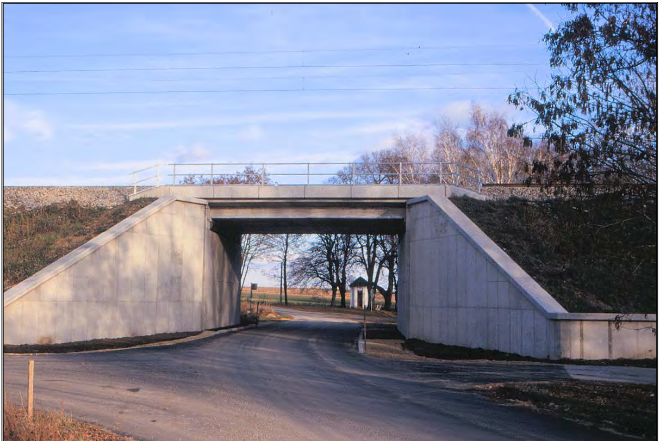
Die fertige Kapellenbrücke
