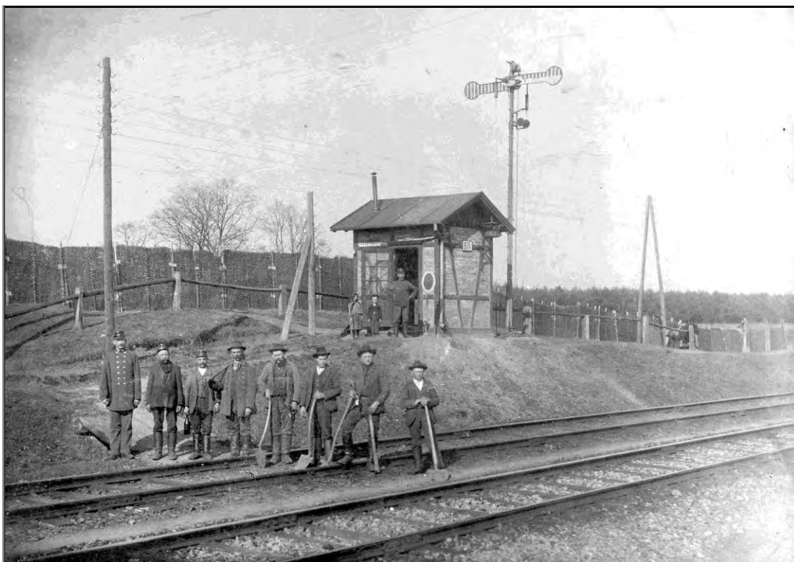
Die von Herrn Obst erhaltene Aufnahme zeigt Block IV mit Doppelsemaphor, davor Oberbauarbeiter, um 1905 (nicht gesichert lokalisiert).
