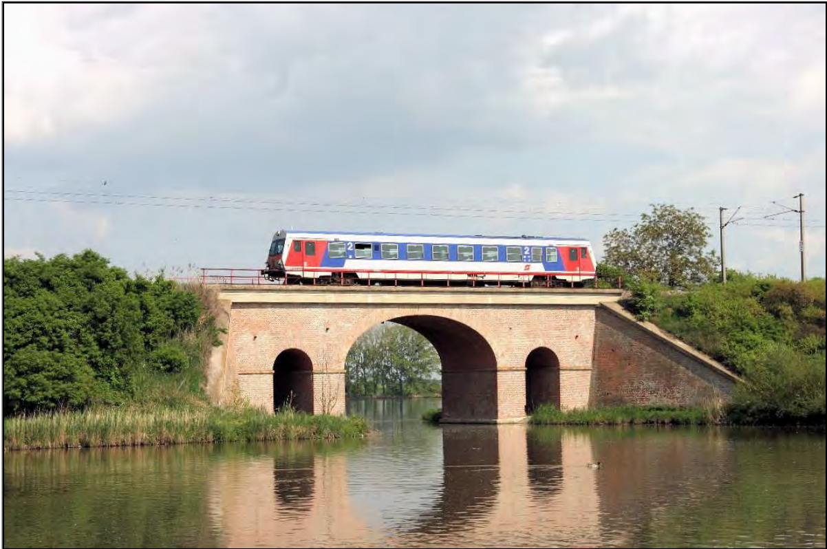
Während der Brückenarbeiten und dem Bahnhofneubau in Břeclav wurde bei eingleisigem Betrieb ein Diesellokomotiv der Reihe 5047 eingesetzt
