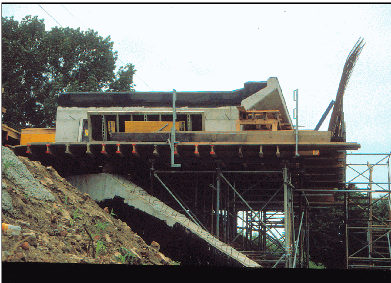
Die Brückenaufleger wurden seitlich vorgefertigt und dann eingeschoben. Mit der gelben Jacke Walter Brunner.
