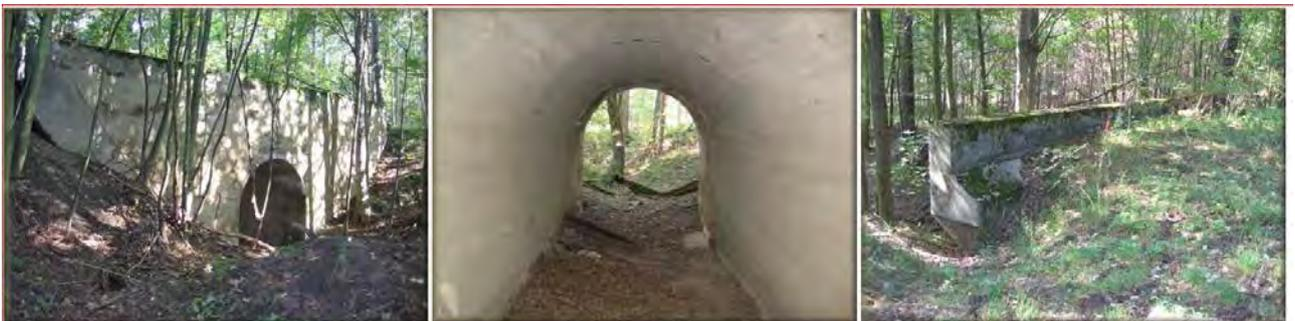
Erhalten sind auch mehrere unterirdische Wasserreservoirs, die in erster Linie zum Löschen möglicher Brände gedacht waren. Einer davon in der Nähe der Hauptstraße wird wahrscheinlich als Lager genutzt. An den Wänden befinden sich Schussspuren von Kleinwaffen, auf der Vorder- und Rückseite befinden sich Inspektionsschächte mit Steigbügel.
