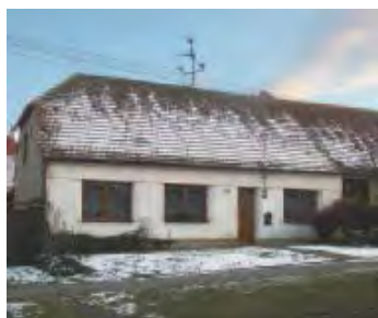
Abb. 2, Haus № 140 in der Samstag-Straße / Obr. 2, Dům č. p. 140 v Sobotní ulici
