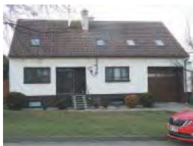
Abb. 1, Haus № 139 in der Samstag-Straße / Obr. 1, Dům č. p. 139 v Sobotní ulici
