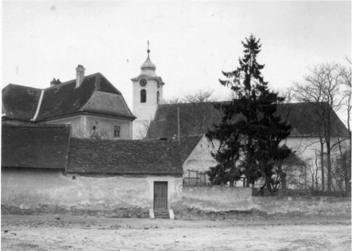
Bild 1, die Pfarrhof-Gartenmauer, Ansicht vom Museumsplatz, 1923.
