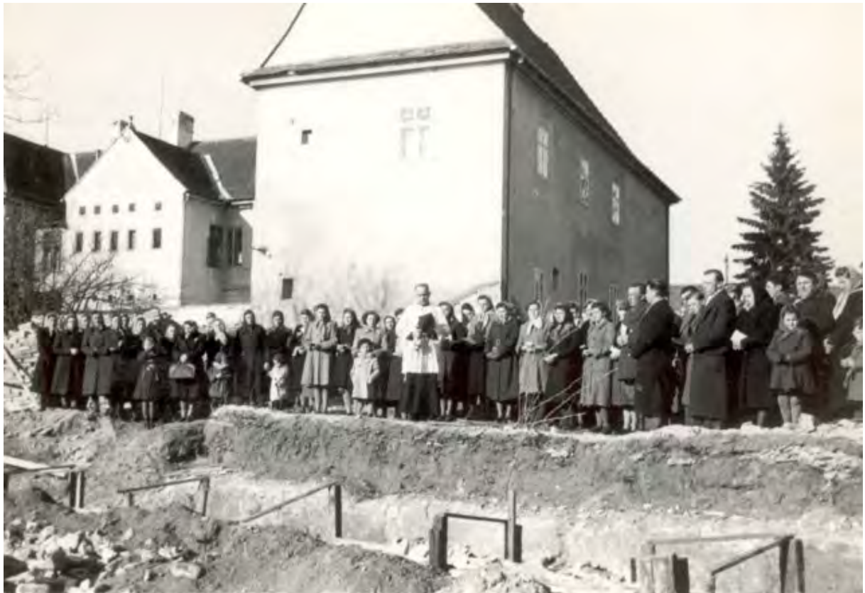
Bild 2, Segnung des Pfarrheim-Fundaments am 19. März 1953 durch Pfarrer Josef Steffler. Im Hintergrund links, das alte Schulgebäude, in der Mitte der Pfarrhof.
