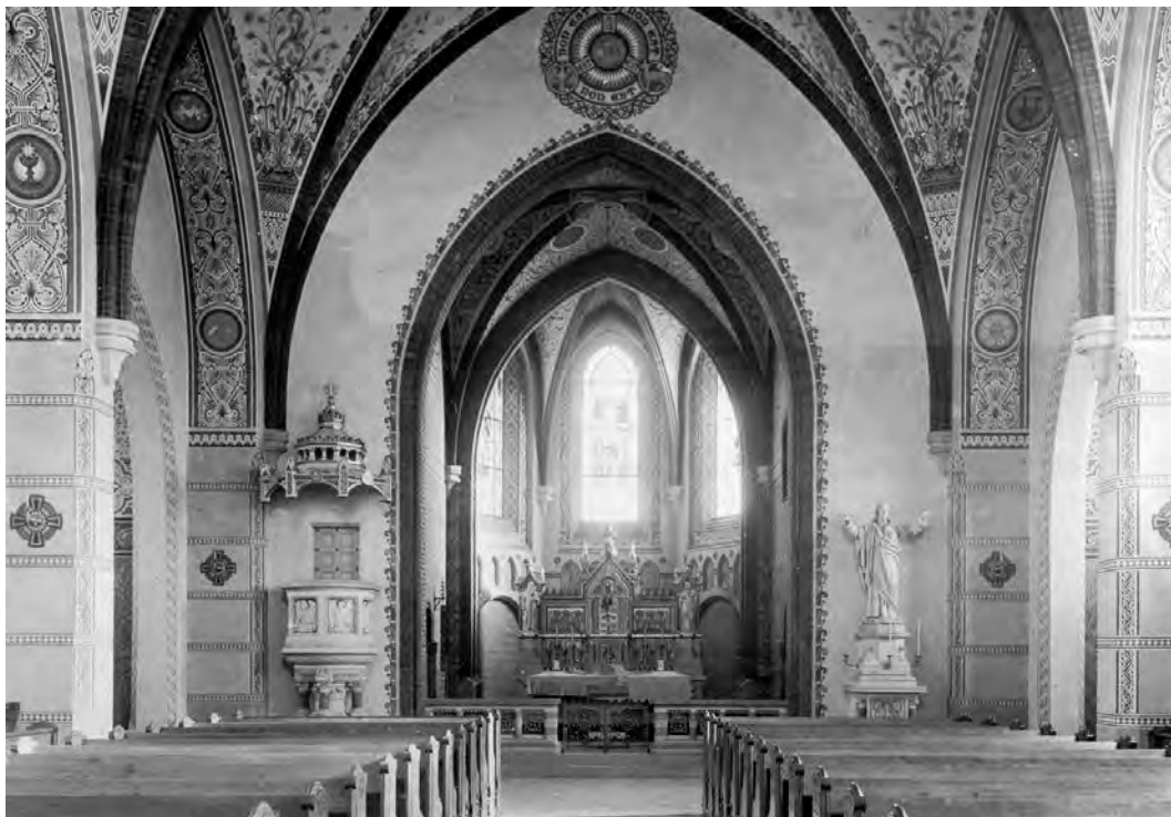
Die neue Pfarrkirche
