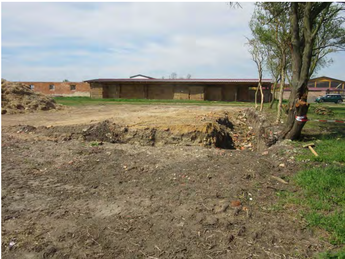
Abb. 20 das Arbeiter-Wohnhaus, April 2023 (2)
