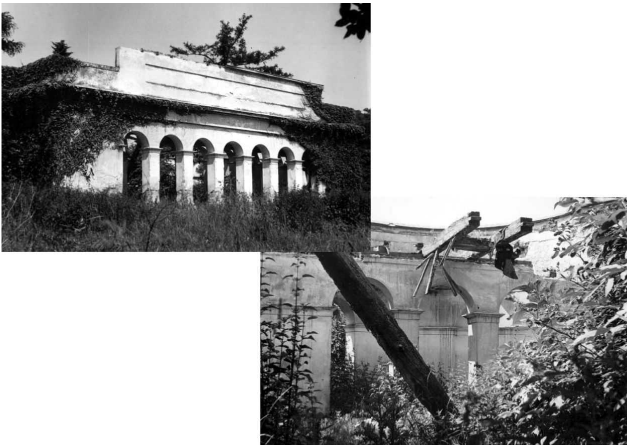
Abb. 37, die vermutlich letzten Bilder des Salettl's, Außenansicht und Vorhalle im Juni 1961.
