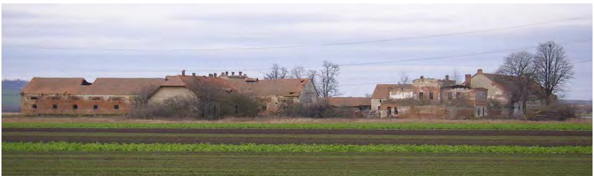
Abb. 16, Meierhof, Ansicht von Bernhardsthal, im Vordergrund das Arbeiterwohnhaus, 2007.
