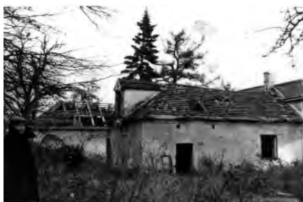
Hájenka po vyhoření – po r. 1956
