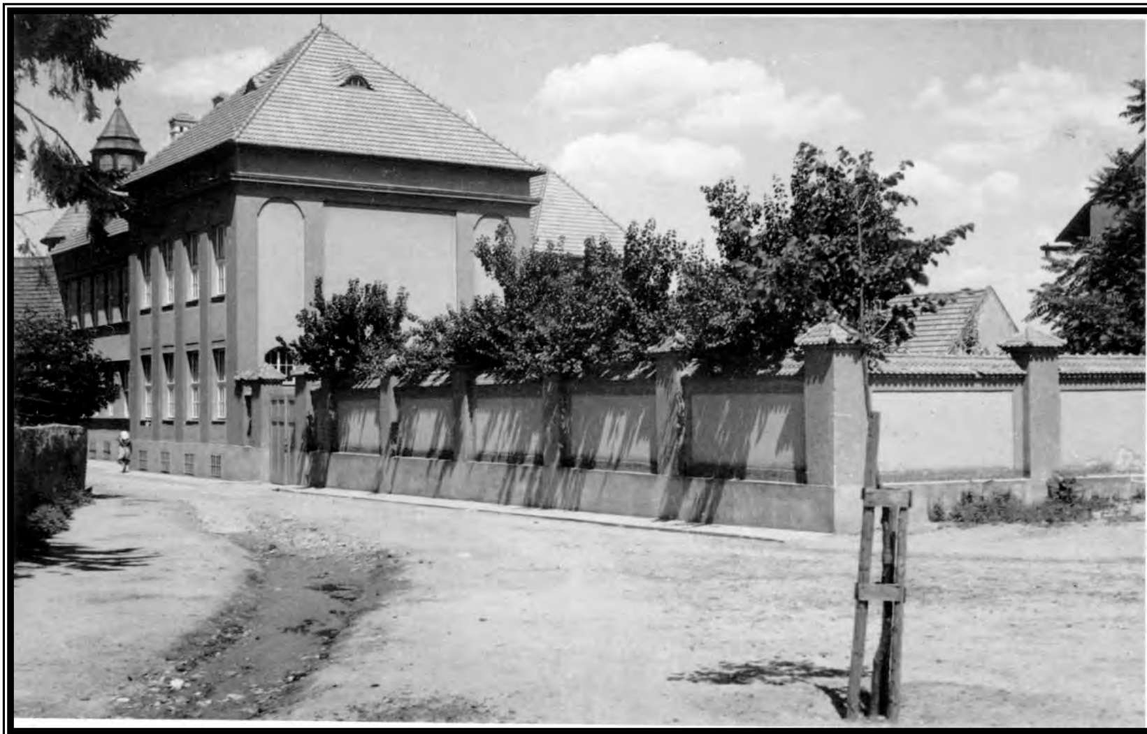
Bild 37, Kloster Südwestseite, um 1935. Die Entwässerung erfolgt noch in einem einfachen Gerinne. Am Platz ist ein frisch gepflanzter Baum zu sehen. Der Klostergarten ist mit einer wuchtigen Mauer eingefasst.
