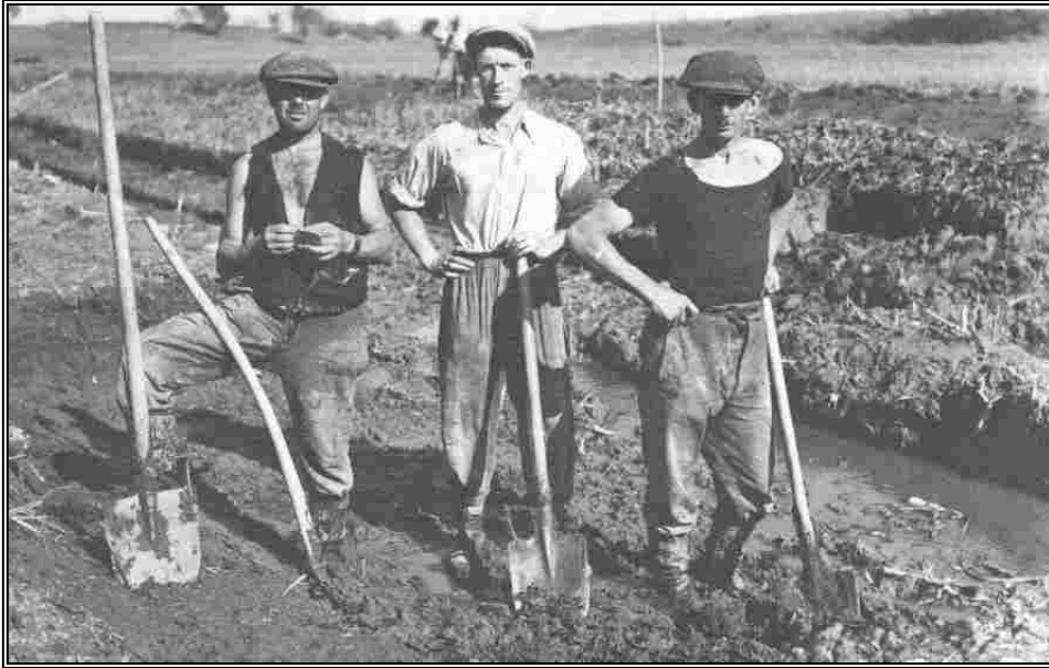
Die Aufnahme der Grabenarbeiter wurde auf den Loslingen, etwa an der Ortsgrenze Bernhardsthal - Reintal, in Richtung Johannes gemacht, rechts im Bild Georg Cetl sen.
