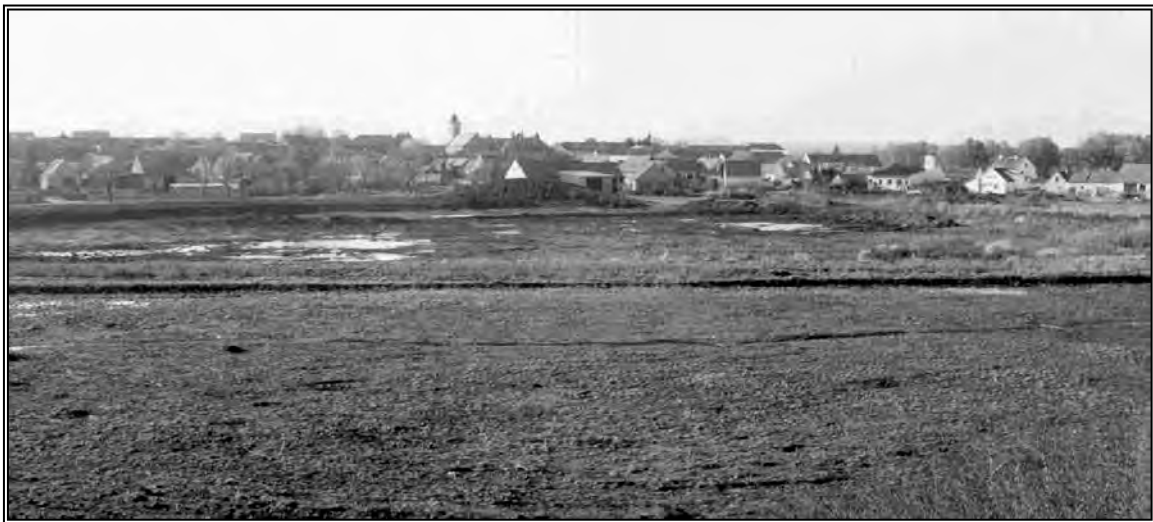
Ausbaggern des kleinen Teichs und Aufschütten des Rodelbergs.
