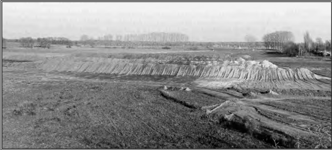
Teilaushub im Südteil des großen Teichs durch die ÖMV.
