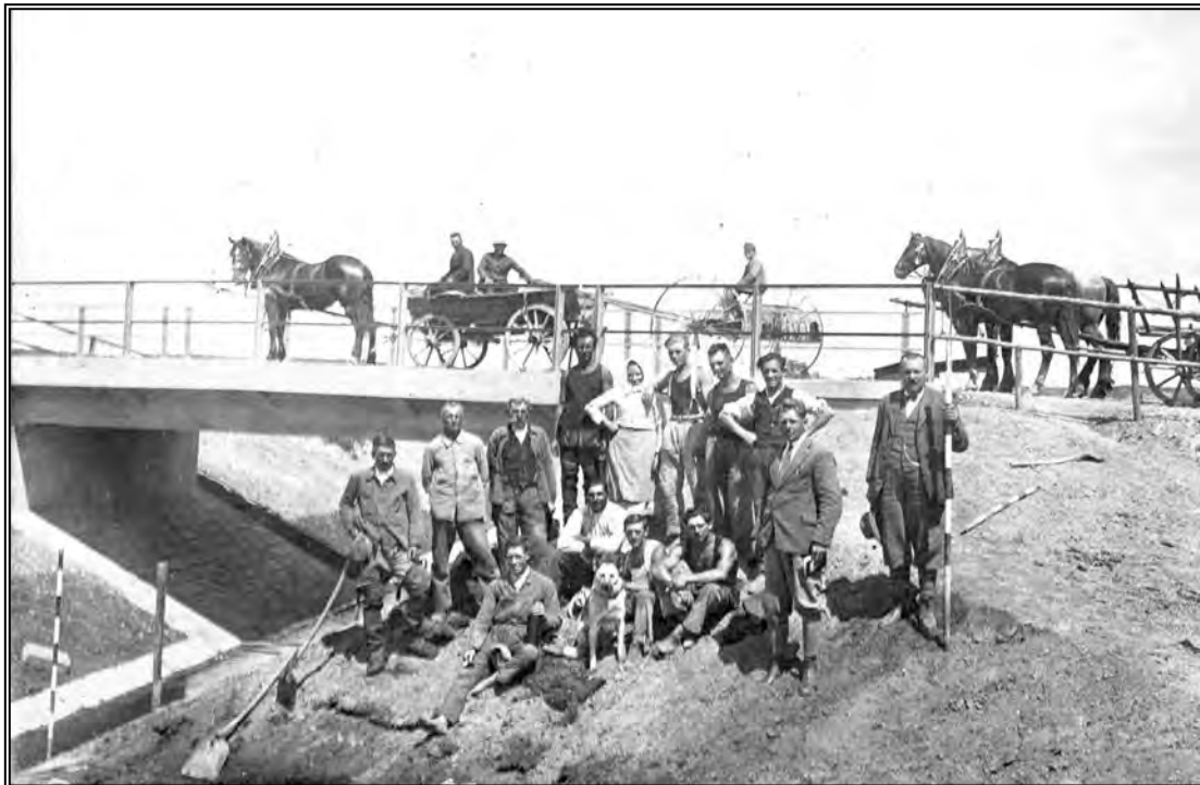
Unter der neuen Brücke ist der mit Betonplatten eingefasste Hamelbach (-kanal) zu sehen. Entlang von Holzpfosten wurde auf jeder Bachseite eine Plattenreihe verlegt.
