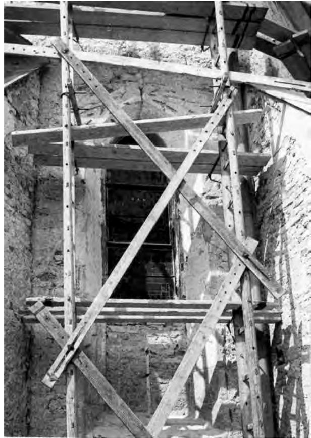
Das linke Foto zeigt das vorderste Nordfenster des Hauptschiffs, links daneben der schräge Anbau der Kreuzkapelle. Ab Fensterunterkante ist außerhalb der Fensterausmauerung nur Bruchsteinmauerwerk zu sehen, hinter der rechten Leiter kann man ein später mit Ziegel ausgemauertes Spitzbogenfenster, wie auf der Skizze eingezeichnet, feststellen. Das rechte Foto zeigt ein Feld zwischen 2 schrägen Stützmauern, die, soweit sichtbar, aus Ziegelmauerwerk bestehen.
