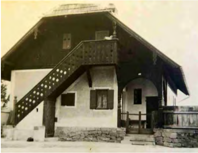
Hegerhaus Ziegelei Architekt: Carl Weinbrenner, 1890
