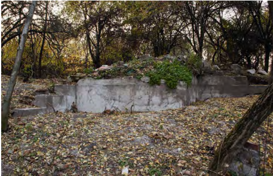
Abb. 15: Die von Daniel Lyčka freigelegten Reste der Salettl-Grundmauern im Jahre 2012.
