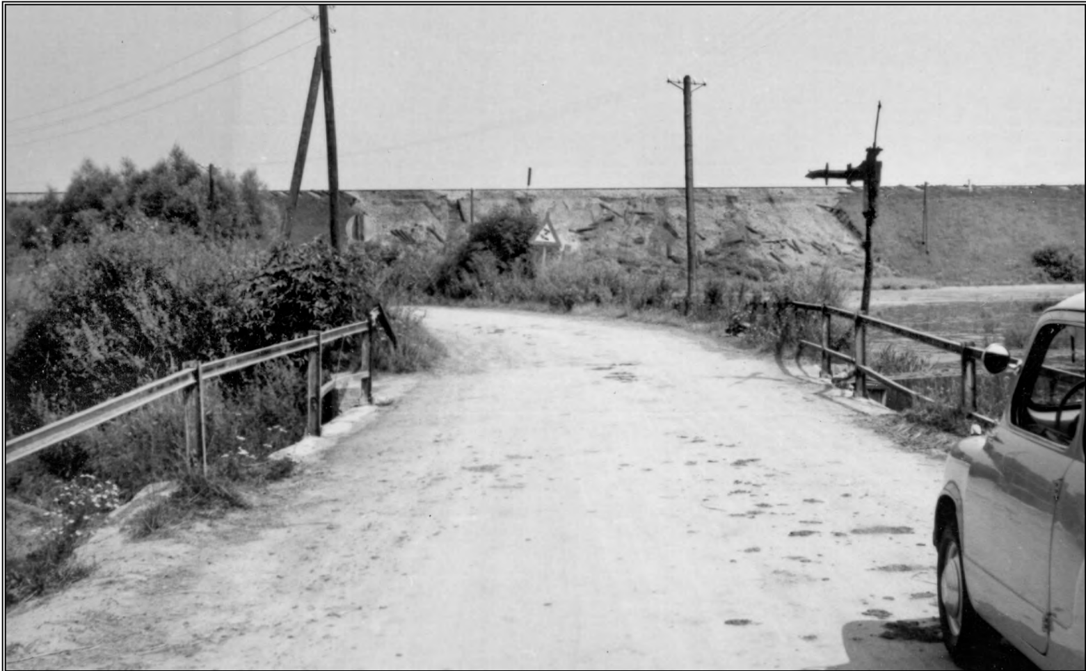
Lundenburgerstraße, dahinter der 1958 abgerutschte Bahndamm, rechts an der Brücke die Wasserentnahme aus dem Hamelbach.
