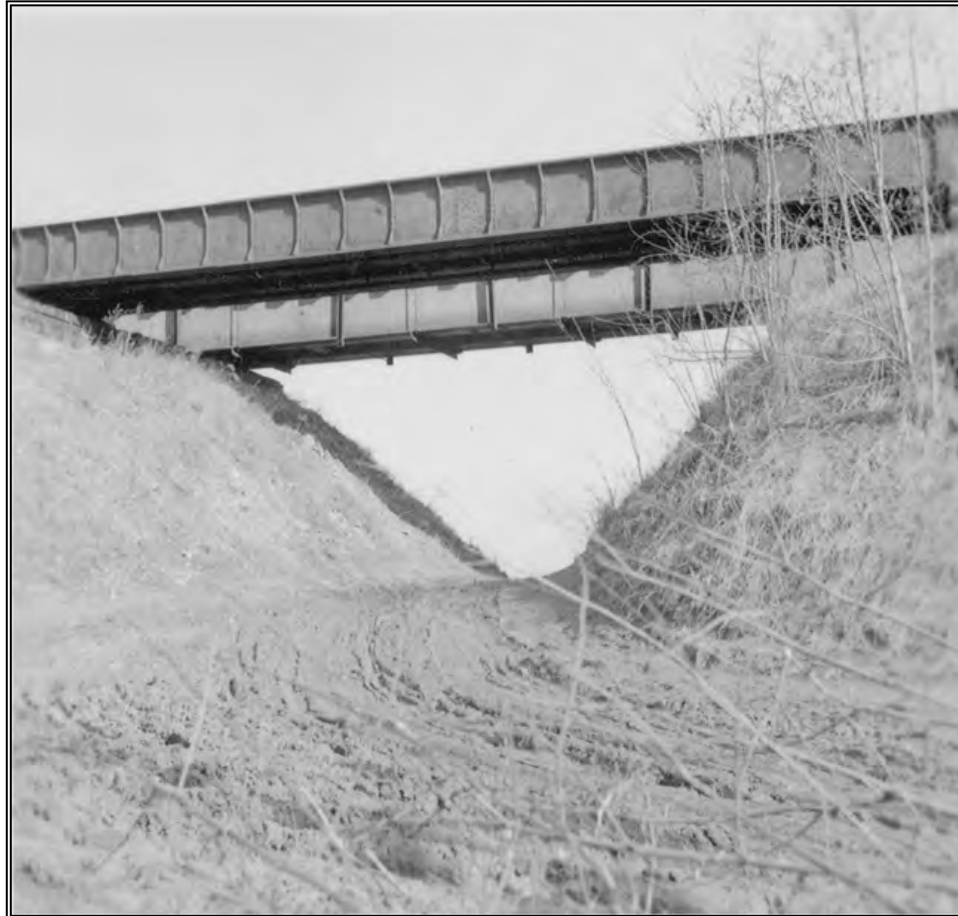
Kapellenbrücke um 1950 2 Eisenkonstruktionen als Ersatzbrücken für die 1945 gesprengte Brücke, das Sprenggut bildete einen Hügel unter der Brücke.
